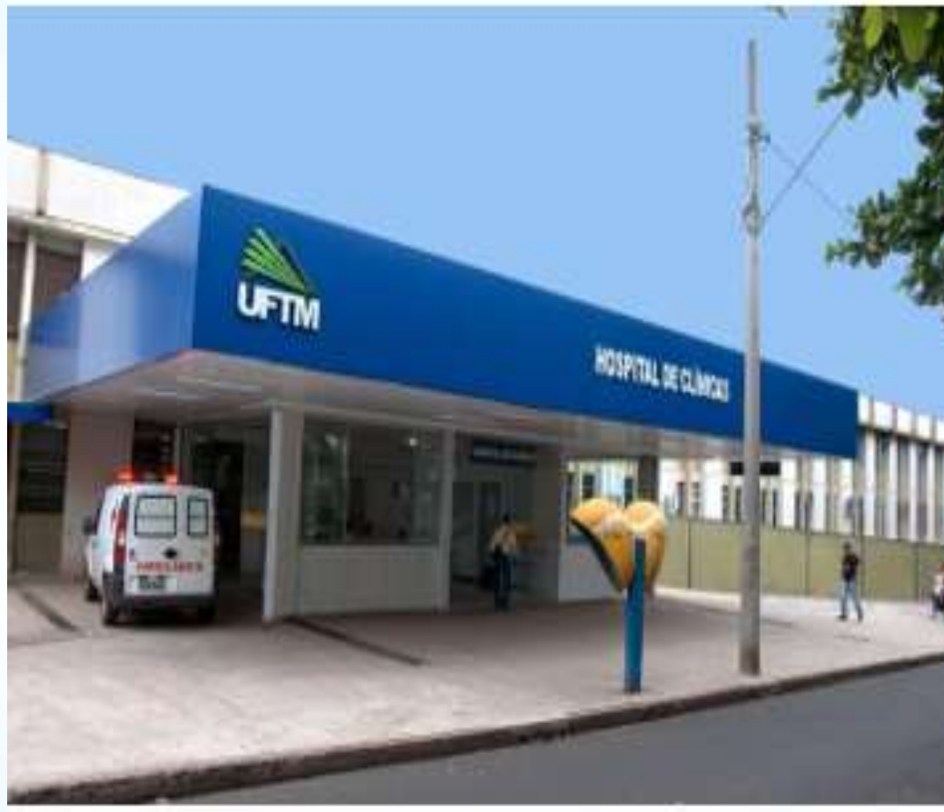
Hospital das Clínicas da UFTM
